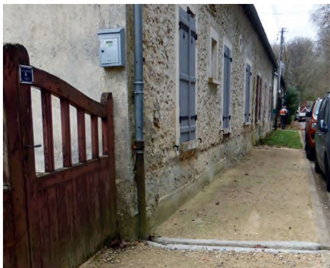
> Réfection du trottoir à Poyers avec remise en état des évacuations eaux pluviales.
