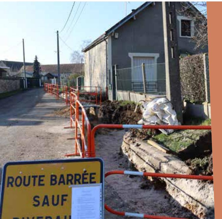
N'ayant pas subi d'intempérie, les travaux se sont déroulés dans les meilleures conditions, ce qui a permis de raccourcir le délai d'exécution pour l'ouverture des tranchées, la pose des fourreaux, des câbles et la mise en place des différents coffrets.
