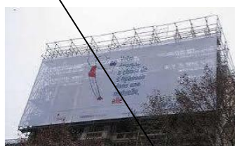
Publicité sur bâche de chantier
